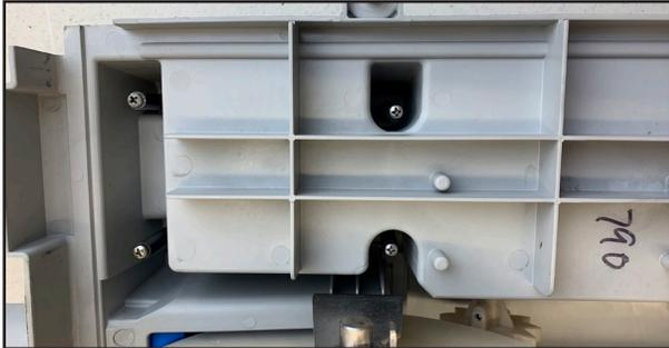
17. Instale los (5) tornillos que removió para quitar el EECA (4) de ellos en frente y (1) en la parte trasera del modulo central.
